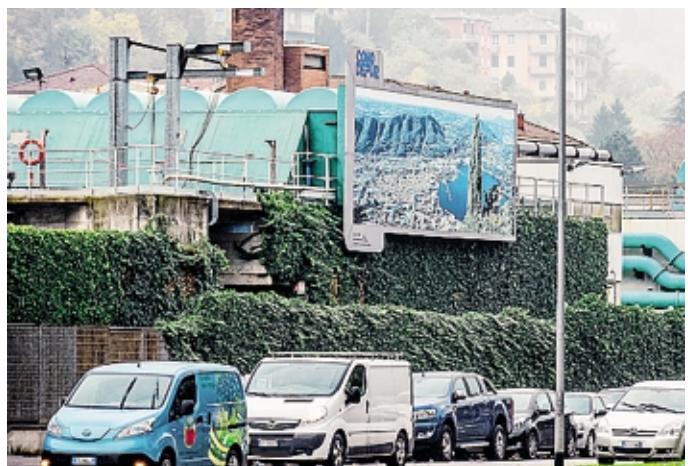
L'impianto di depurazione in tangenziale BUTTI
